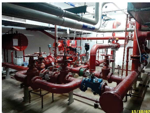
เครื่องปั้มน้ำดับเพลิงชั้นใต้ดิน และตู้ควบคุม
