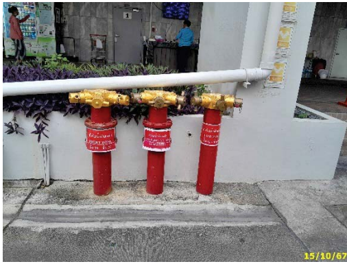
หัวต่อสายฉีดน้ำดับเพลิงชนิดหัวต่อสวมเร็ว
