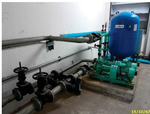
Booster Pump ชั้นดาดฟ้า
