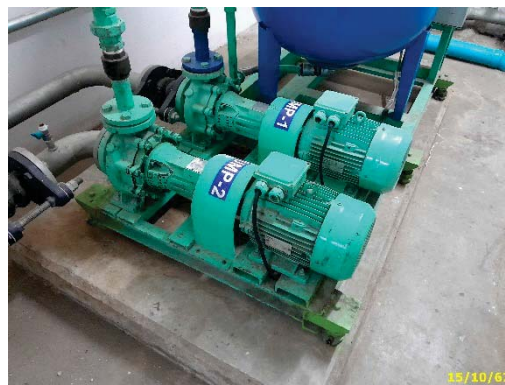
Booster Pump ชั้นดาดฟ้า
