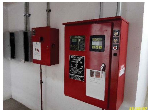
เครื่องปั้มน้ำดับเพลิงชั้นใต้ดิน และตู้ควบคุม
